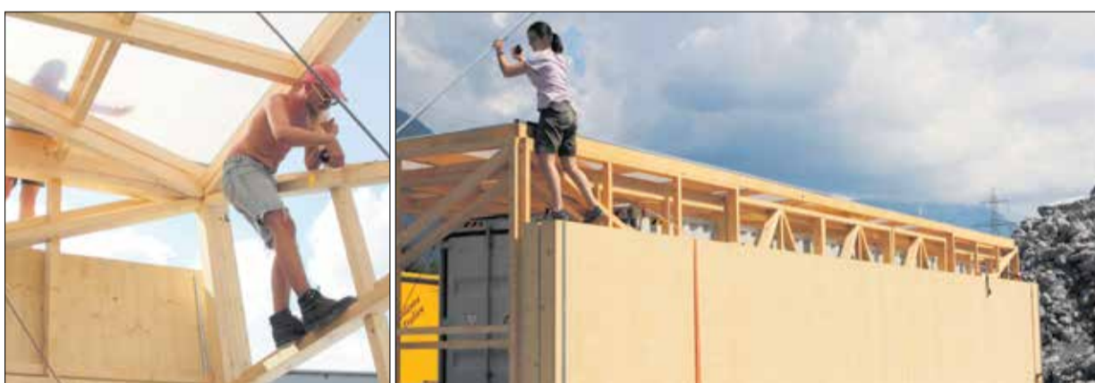
Studenten der Uni Liechtenstein haben den Raum der Schaffarei ersonnen und gebaut.
